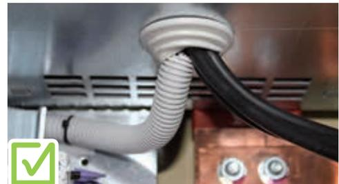
Se utilizan prensaestopas para proteger los cables del agujero de la lámina.
