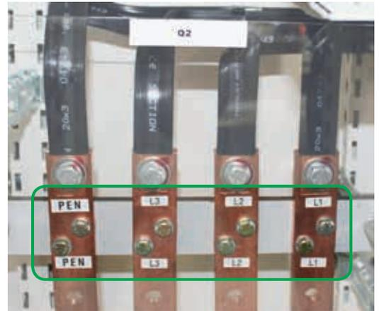
**2** Las fases se deben marcar como mínimo L1, L2, L3 al final de los puntos de conexión. No se requiere ningún color específico. Tampoco es necesario la identificación continua en toda la longitud de la barra.
