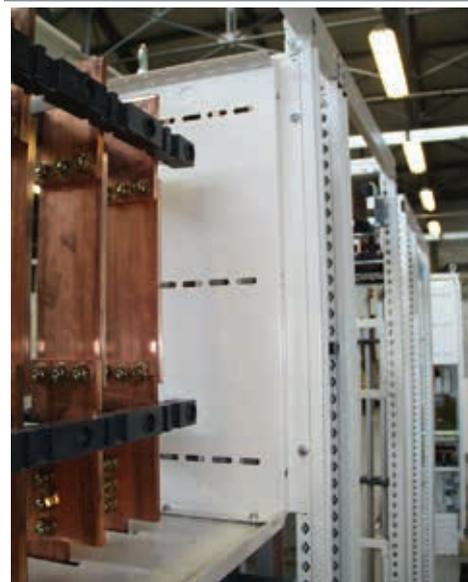
Conexiones verticales desmontables
